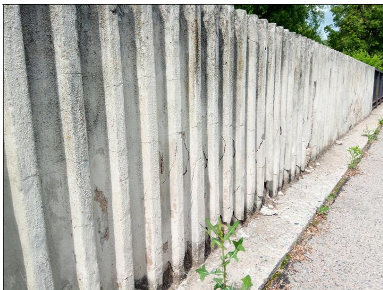
Trhliny v betonových zábranách.jpg
