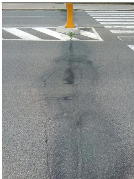
Příčná trhlina.jpg
