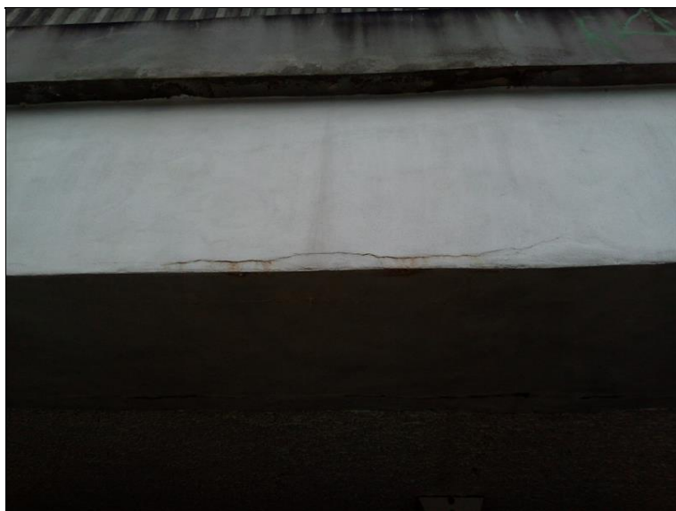
Vodorovná trhlina na pravé římse.jpg
