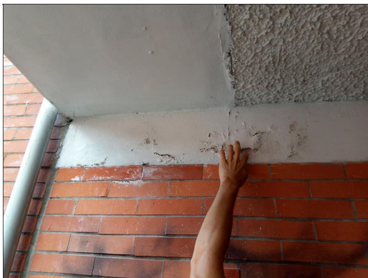
Vlivem vlhkosti odpadávající nátěr na krajích obou podpěr.jpg
