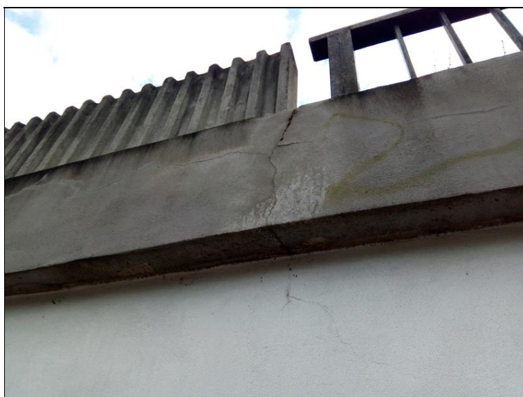
Svislá trhlina na pravé římse.jpg
