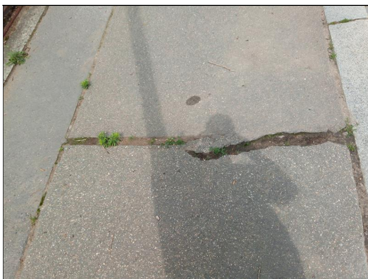
Příčná trhlina v chodníku.jpg
