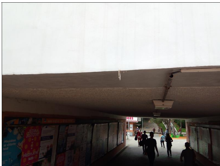
Stalagtitý na levé římse.jpg
