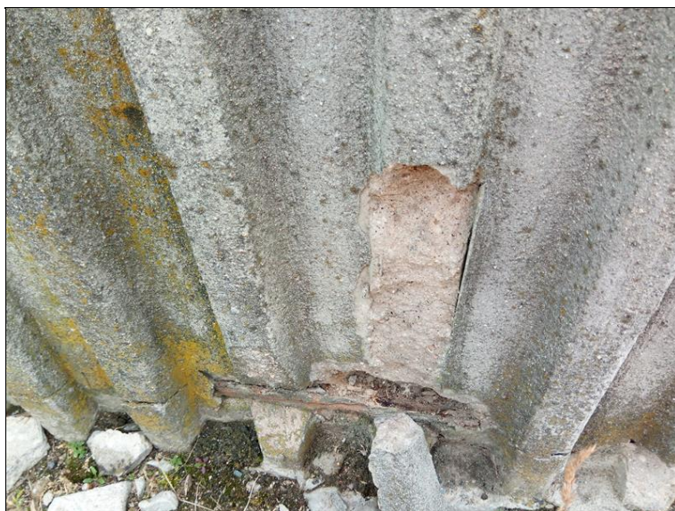
Betonové zábrany na obou stranách značně degradují.jpg
