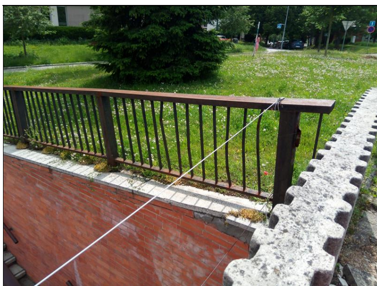
Deformace zábradlí nad křídlem OP2 vlevo.jpg
